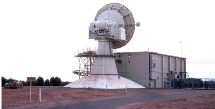
Carnarvon Q6 radar
